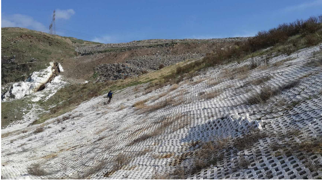
Şekil 15. Sedde üzerindeki kabarmalar.
